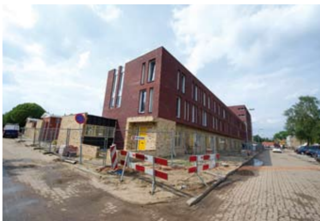
Klimopstraat: woningen in aanbouw
